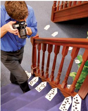
La maggior parte dei rivenditori Minivator utilizza l'avanzata tecnologia eSurvey per eseguire il rilievo delle scale curve. Questo speciale sistema elettronico massimizza la precisione del rilievo di una scala curva, riducendo contemporaneamente i tempi necessari.
